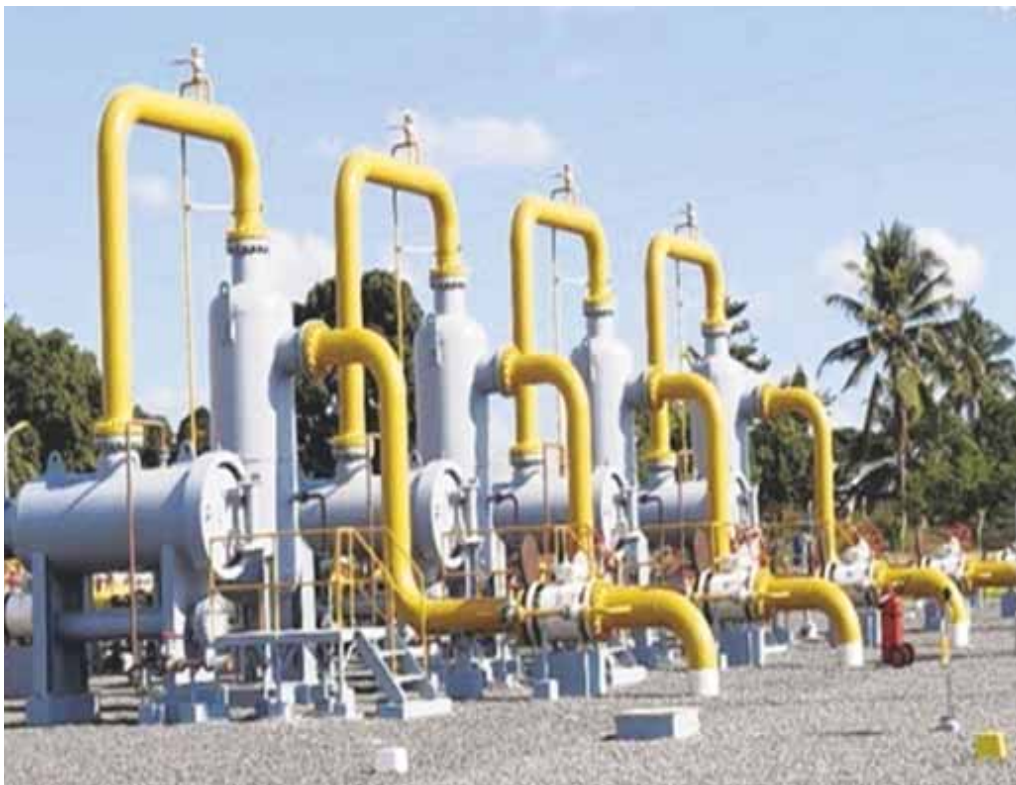
Foto: Proyecto de gasoducto, Mtwara, Dar es Salaam.
